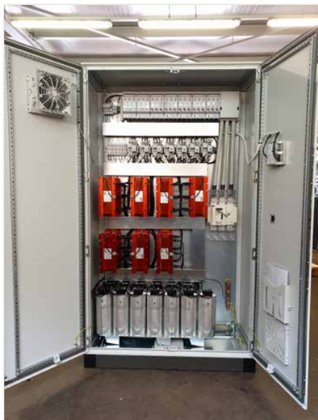
Samodejna kompenzacijska naprava (ETI PROSTIK)
