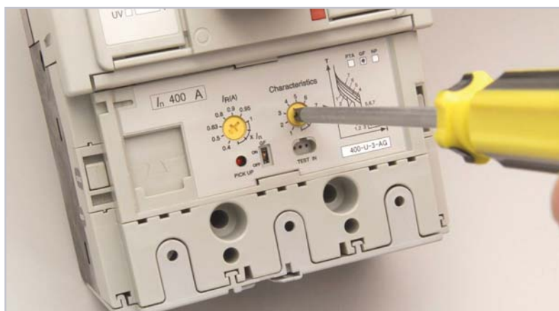
Izbira trenutne karakteristike na 400A Etibreau z mikroprocesorskim sprožnikom
