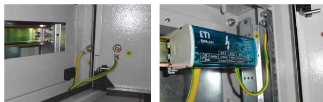
Slika 19: Priklučitev ozemljitvenega kabla
