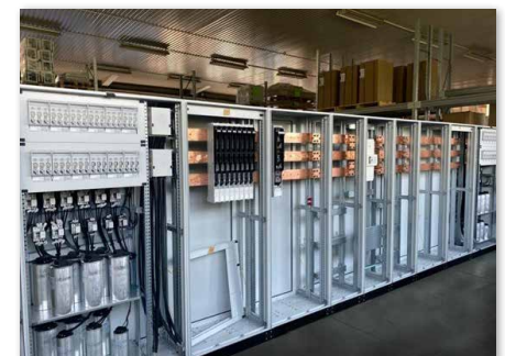
Rys. 1 Proces prefabrykacji rozdzielnic niskiego napięcia wyposażonej w baterię kondensatorów oraz listwowe rozłączniki bezpiecznikowe
