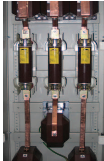
Povezave v notranji stikalni napravi, primer:
