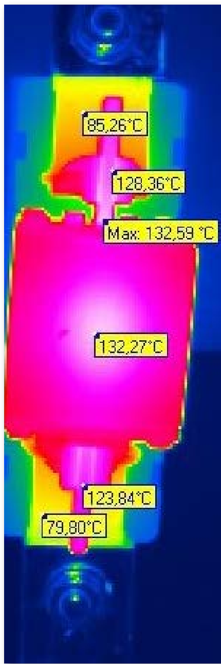
Merjenje temperature na podstavku PK 2 s pomočjo termovizije
