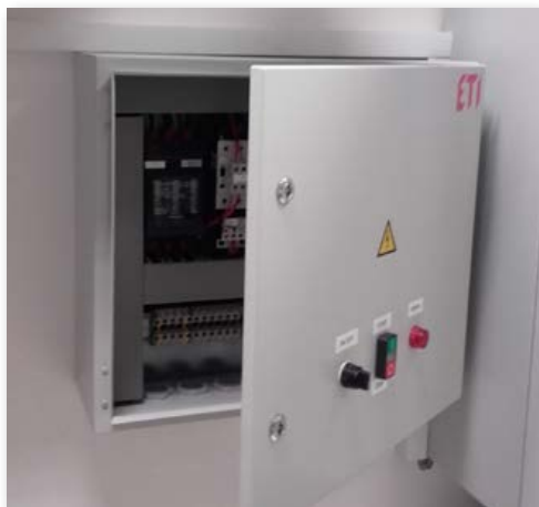
Omarica s pripadajočo opremo podjetja ETI, s katero dijaki izvajajo zagone asinhronskega motorja pri praktičnem pouku.
