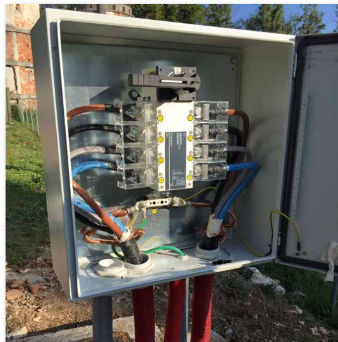
Omarica z bremenskim ločilnim preklopnim stikalom
