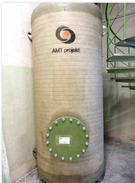
Nova cisterna za odpadno vodo
