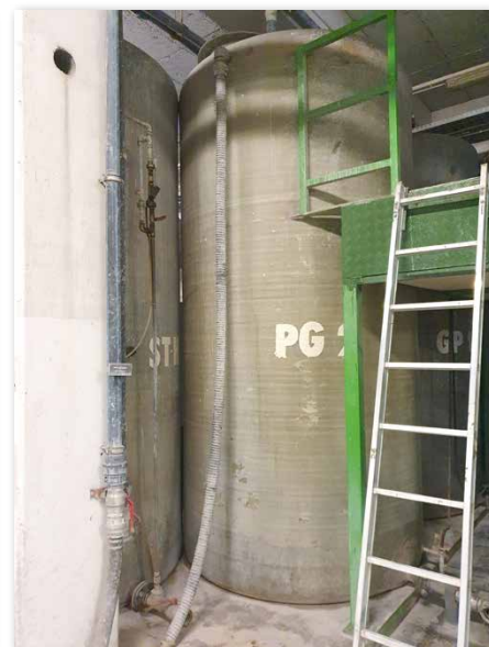
Obstoječe cisterne za odpadno vodo
