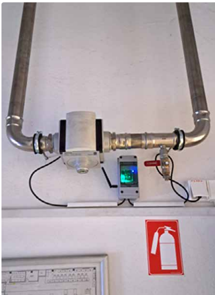
Elektromagnetni ventil EMS s krmiljenjem pred oddelkom montaže
