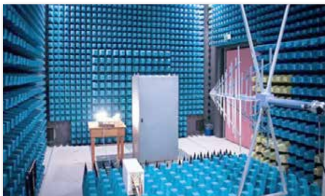
Pomieszczenie do badania kompatybilności elektromagnetycznej EMC [8]
