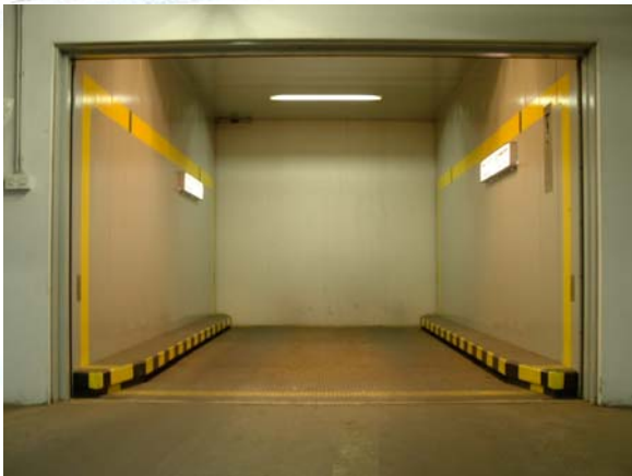
Avtomobilsko hidravlično dvigalo z mehkim zagonom
