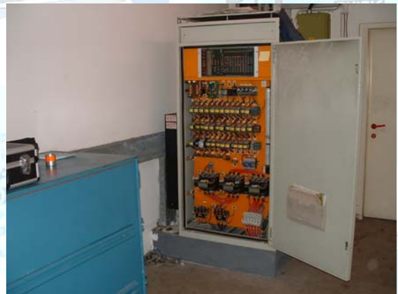
'Regulacija zvezda-trikot za asinhroni trifazni motor', predvsem starejše izvedbe dvigal.
